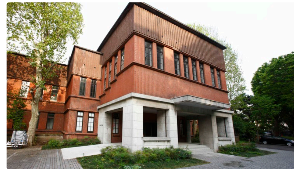
赤煉瓦造りが美しい南研究棟の2階、3階部分を改修しました。
